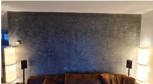
Stucco Antico: Glättespachteltechnik für marmorverwandte Effekte im Innenbereich
